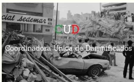
El “CUD”, una organización civil formada por las víctimas de los terremotos de septiembre de 1985 en la Ciudad de México.
