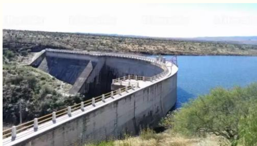
Infraestructura hidráulica casi vacía en Aguascalientes, 2024.
