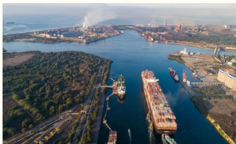
Puerto Lázaro Cárdenas en Michoacán.
